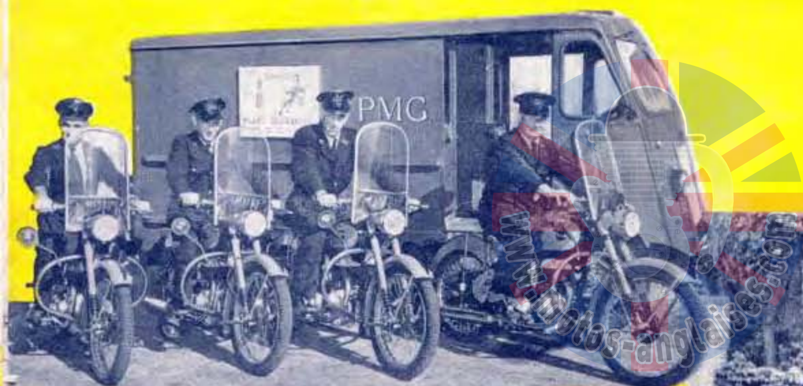
En Australie comme en Grande-Bretagne, les services postaux emploient un grand nombre de motocyclettes. Sur la photo ci-dessus, quatre agents du "Postmaster General's Department" de Perth viennent de prendre livraison de nouvelles machines B.S.A. de 250 cmc.
